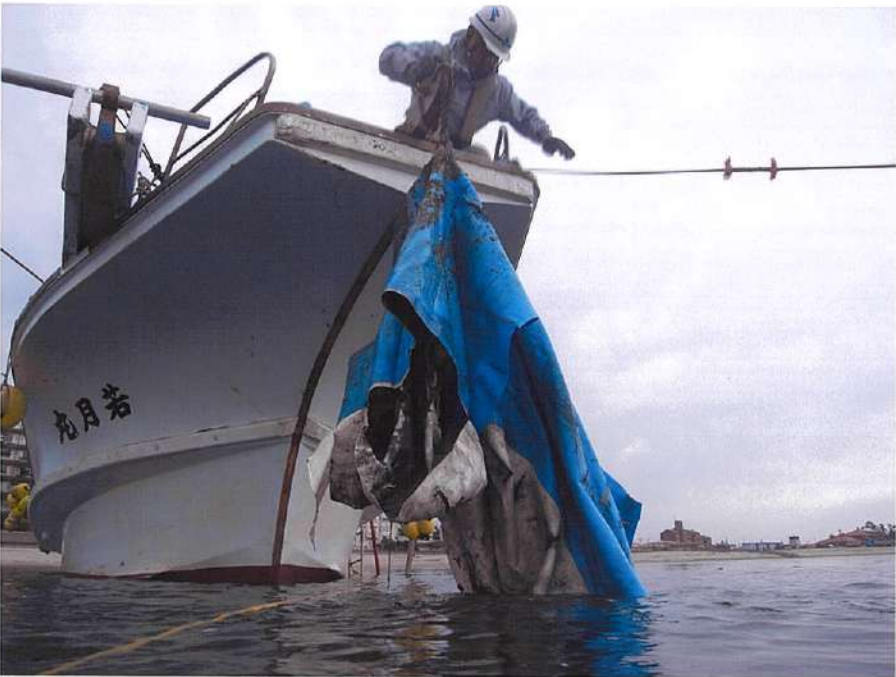
場所：東側離岸堤 状況：潜水土船へ引揚げ
